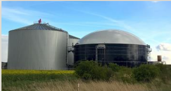
Slika 6: Biogazno postrojenje https://vojvodinaizv.rs/hpp-bioenergy-u-dolovu-gradi-biogazno-postrojenje-za-proizvodnju-elektricne-energije/
